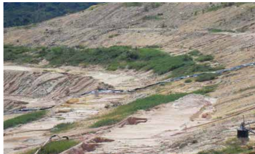
Foto1: Ausência de recobrimento vegetal nas células de deposição vem gerando sérios problemas ambientais
